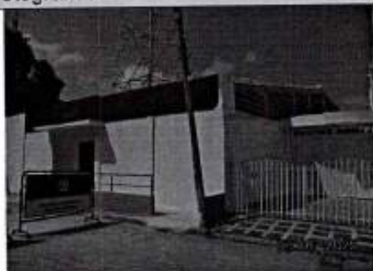
Descripción Registro Fotográfico: Vista
