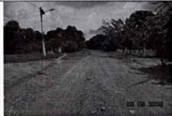
Descripción Registro Fotográfico: Tramo Final – Grafico Nro. 5
